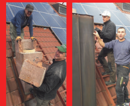
Horst Sailer (l.), Christian Steinbrecher (r.) und Markus Bernhard beim Kaminabbau.
